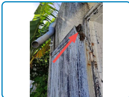
Champignon de pourriture molle - Précision : Dégradations liées à la présence de pourriture sur Volet Bois
