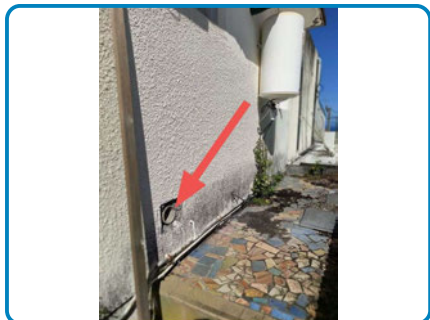
D.O. n° 1 sur Conduit Aération Fibres ciment
